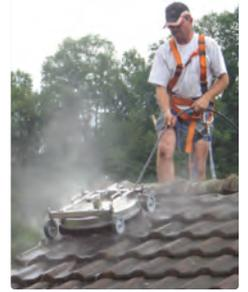
Komplett Edelstahl. Reiniger mit zusätzlichem Rahmen für höchste Stabilität. Höhen- und Breitenverstellung: max. 33 mm (Höhe) und 90 mm (Breite). Es werden 2 Düsen benötigt. Inklusive einer Sicherheitsöse zur Befestigung des Sicherungsseils mit Karabinerhaken. Wir empfehlen die Nutzung der Fußbetätigung ST-550. 4 Industrierollen (125 mm).
